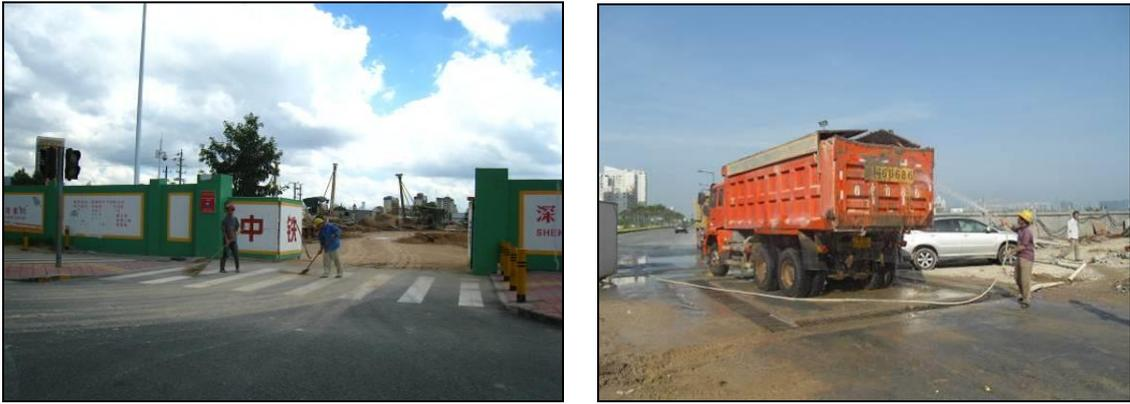
图 10.1-3 施工场地清扫和车辆清洗
