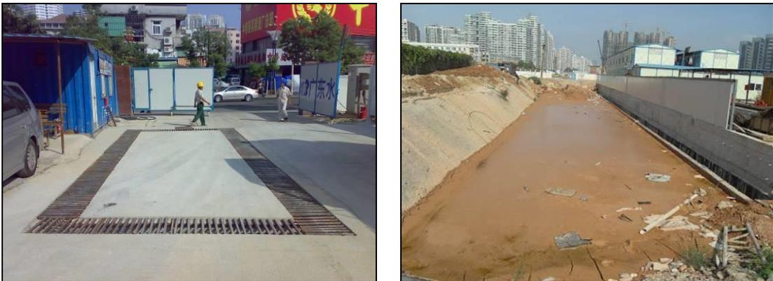
图 10.1-2 施工场地车辆清洗设备及泥浆干化池
