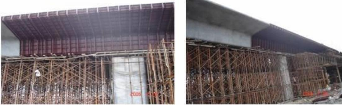
图 2.2-5 支架现浇法施工照片
