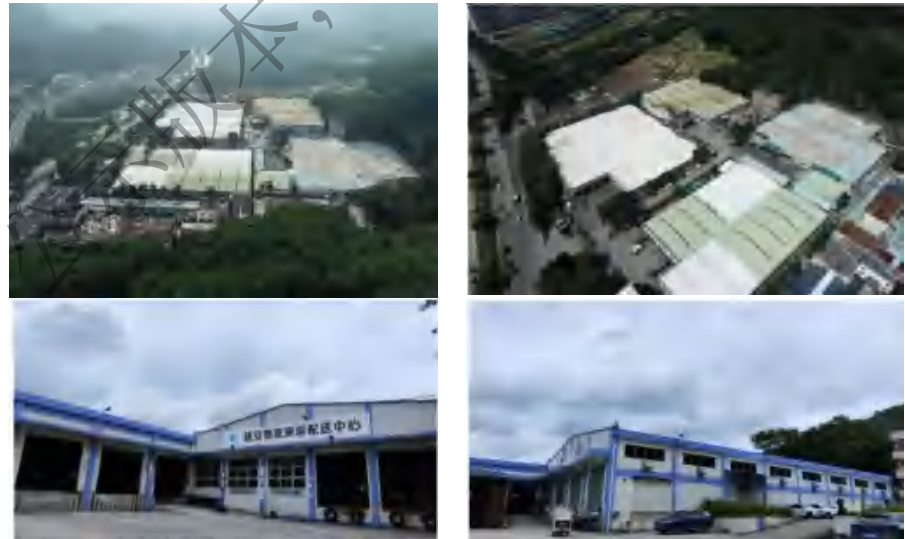
图 8.8-5 工程占地区域现状照片
