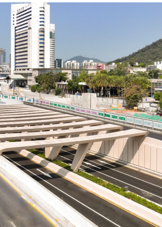
• 黄木岗交通枢纽下沉隧道
