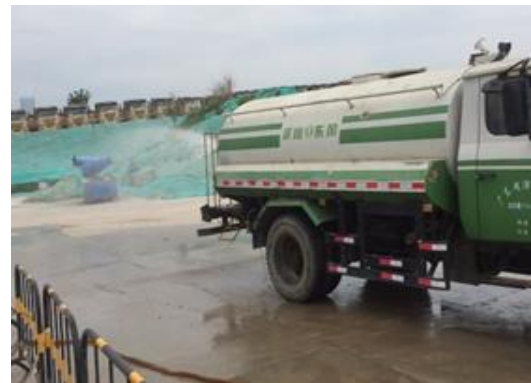
施工场地洒水
