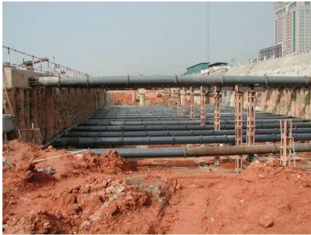
图 2.1-16 明挖法施工现场
