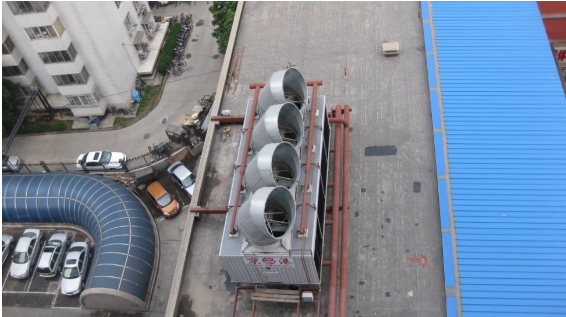
图 5.1-1 冷却塔安装导向消声器实施实例
