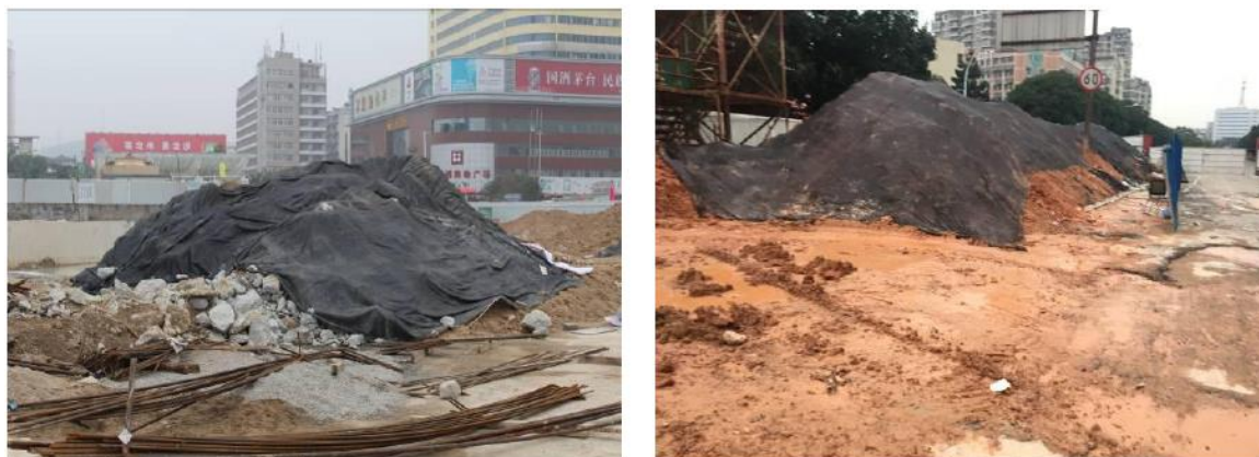
施工现场土方覆盖
