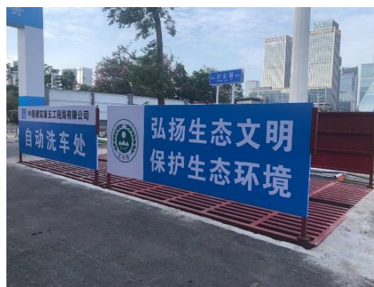
施工文明施工标示
