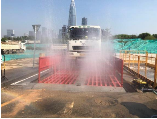
施工车辆冲洗
