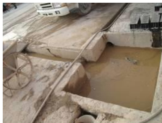
施工场地沉淀池
